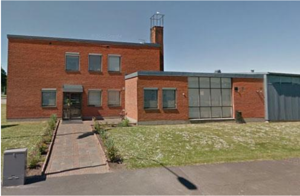
Entrén sedd från Norra Stationsgatan.
